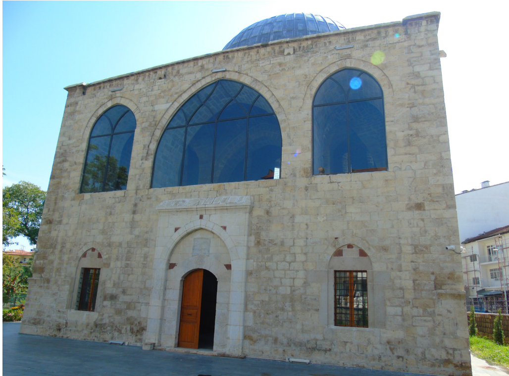
Şekil 5: Taşhoran Kilisesi, Batı Cephesi, Restorasyon Sonrası 2020
