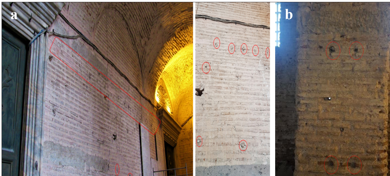
Resim 11: (a) Dış Narteksin Doğu Yönündeki Duvarında Mermer Takoz Sıraları, (b) Dış Narteks Tonzolarını Taşıyan Tuğla Ayaklardaki Taş Takozlar ve Takoz Yuvaları
