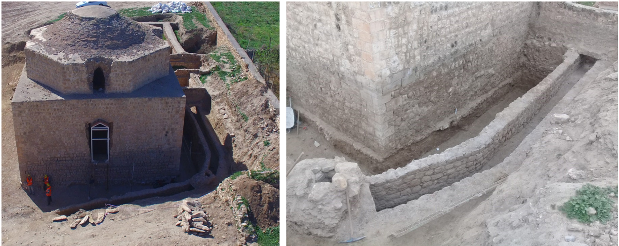
Resim 12: Atık Su Kanalı (KVMGM Arşivi).
