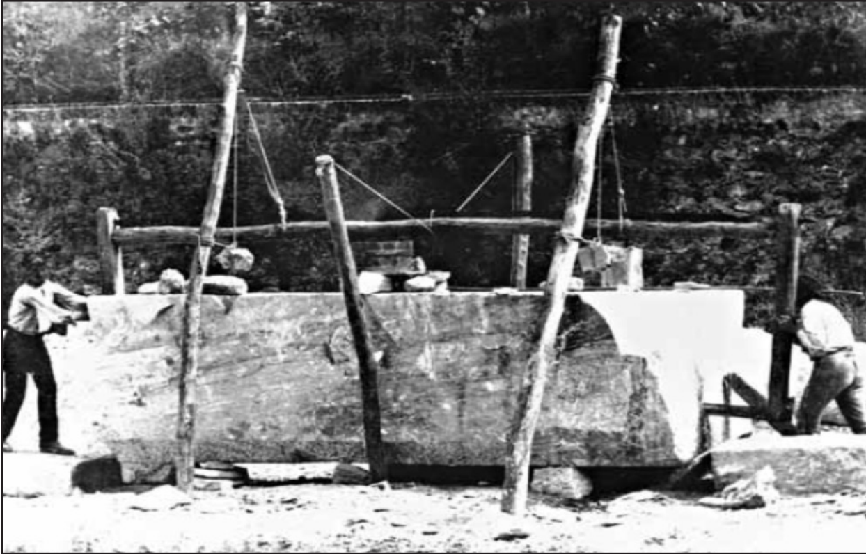
Resim 6: Sarkaç Testere ile Taş Kesen İşçiler 20.yy. (Kessener, 2010)
