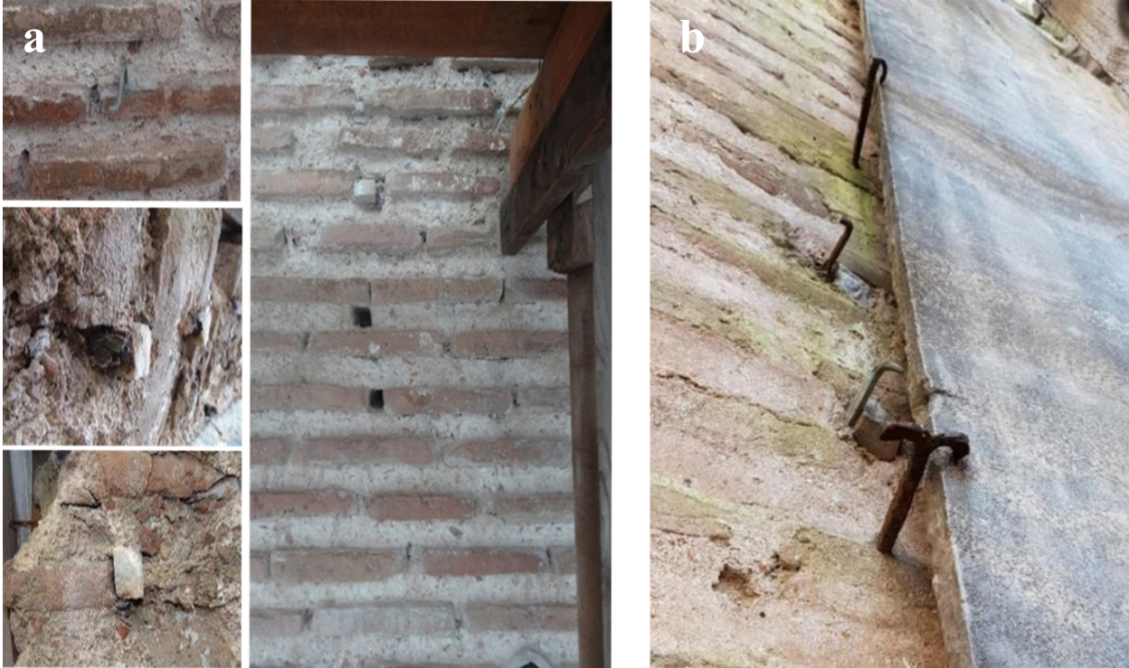
Resim 9: (a) Duvarda Tespit Edilen Taş Takozlar; (b) Farklı Özellikteki Metal Donatılar ve Dış Cephe Kaplama Taşı
