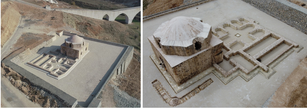
Resim 24: Hamamın Yeni Yeri Montajı ve Aralık, Ilıklık, Sıcaklık, Külhan ve Sarnıcın Plan Düzleminde Sunumu (KVMGM Arşivi)
