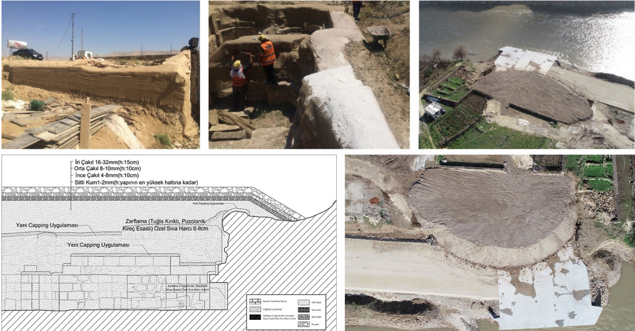
Resim 25: Aralık, Ilıklık, Sıcaklık, Külhan ve Sarnıcının Özgün Yeri Koruma Uygulamaları (KVMGM Arşivi)
