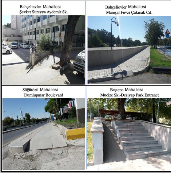
Şekil 17. Sorunlu Rampaların Eğim Açısından Örnek Görünümleri (Yazar, 2021; bu görsel yazar tarafından oluşturulmuştur).
