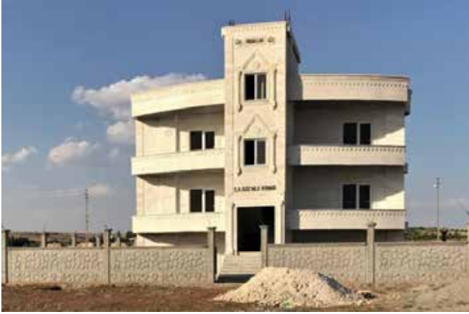
Foto 14: Yeni bir müstakil taş ev örneği. Photo 14: An example of a new detached stonehouse.
