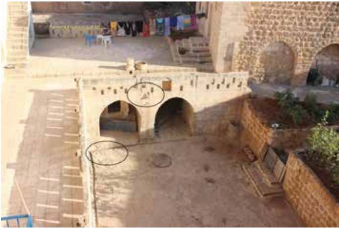
Foto 8: Geleneksel evlerdeki açık alanlara düşen yağış sularının toplanmasında kullanılan kanal ve oluklar.
