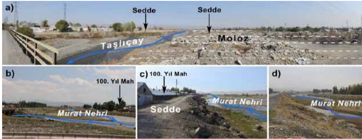
Foto 2: Ağrı şehri etkileyen Taşlıçay'ın çevresine yapılan seddelerin olası büyük taşkında aşılması durumunda şehrin büyük bölümü etkilenecektir (a). Ağrı şehri güneyinde Murat Nehri çevresinde yapılan setlerin de büyük taşkınlarda aşılabacağı düşünülmektedir (a, b, c). Çünkü bu setler 2000 yılından sonra dere yataklarındaki meskenleri korumaya yönelik yapılmıştır.
