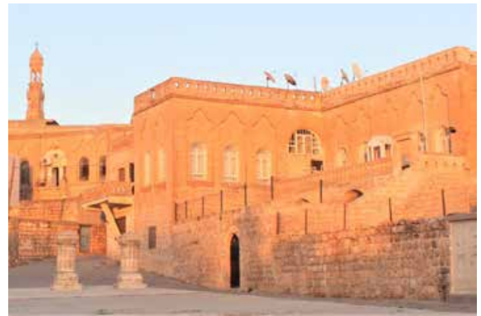
Foto 2: Midyat taşından yapılmış duvarlar zamanla kuruyarak kırmızıya dönmekte ve binalar arasında renk bütünlüğü oluşturmaktadır.
