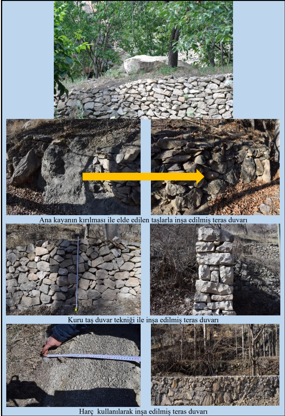
F. 3. Tarımsal teras duvarı yapımında kullanılan malzemeler-çevre ilişkisi
