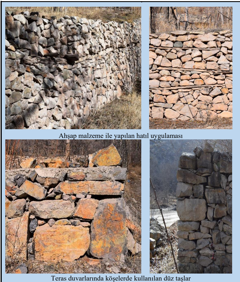
F. 4. Teras duvarlarında hatıl uygulaması
