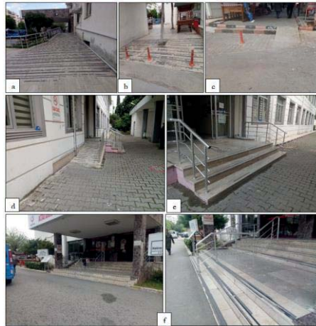
Şekil 3. (a) Ana poliklinik giriş rampası, (b) Rampa görüntüsü, (c) Kaldırım rampası ve basamaklar, (d) Ek poliklinik bina giriş rampası (e) Ek poliklinik bina giriş merdiveni, (f) Ana poliklinik bina giriş merdiveni
