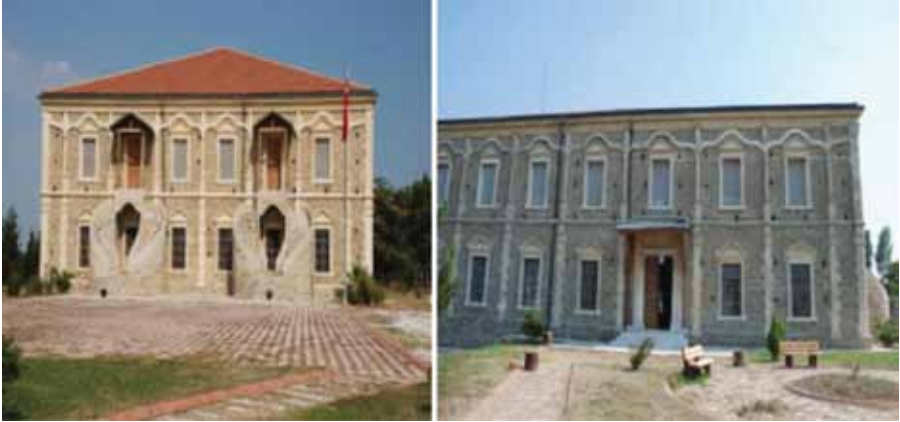
Resim 7-a ve 7-b: Solda Gelibolu Mevlevihanesi'nin günümüzde batı cephesi ve sağda kuzey cephesi görülmektedir (Fotoğraf yazar tarafından belgelenmiştir).
