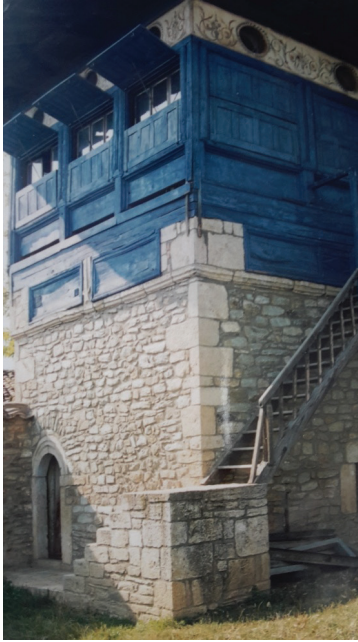
Resim 12: Fatma'nın Evi (Harem Dairesi), güneydoğu ve kuzeydoğu cephesi (Yazarın çektiği fotoğraf)
