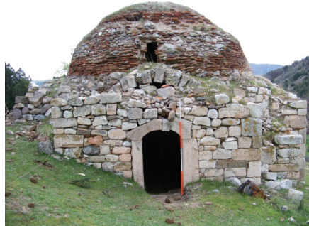
Fotoğraf: 6) Batı cephe
