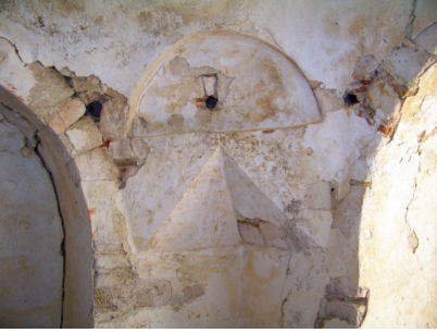
Fotoğraf: 9) Geçiş sistemi ve künkler
