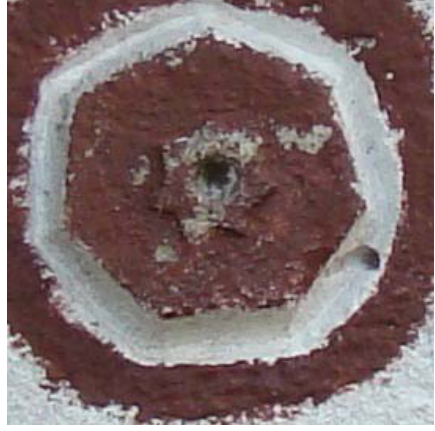
7. Otman Baba Türbesi çevre duvarında yedi köşeli yıldız
