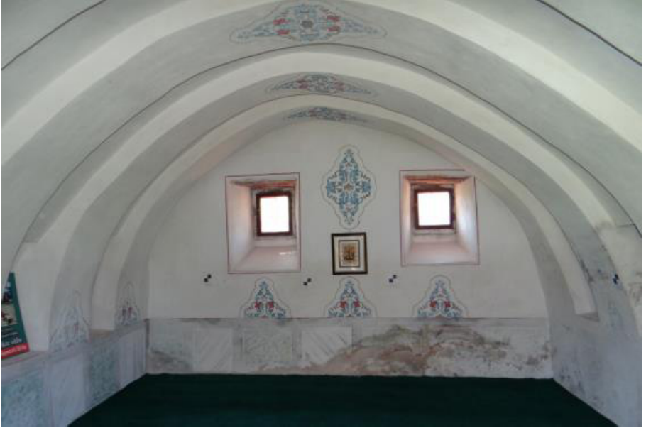
Fotoğraf 13. Cem Odası güney duvarı.
