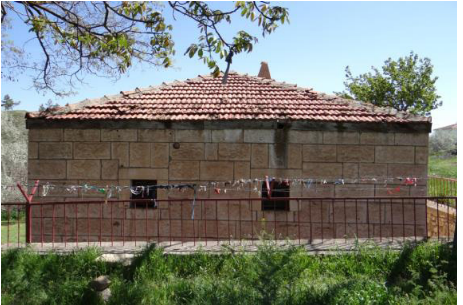
Fotoğraf 6. Batı cephe.
