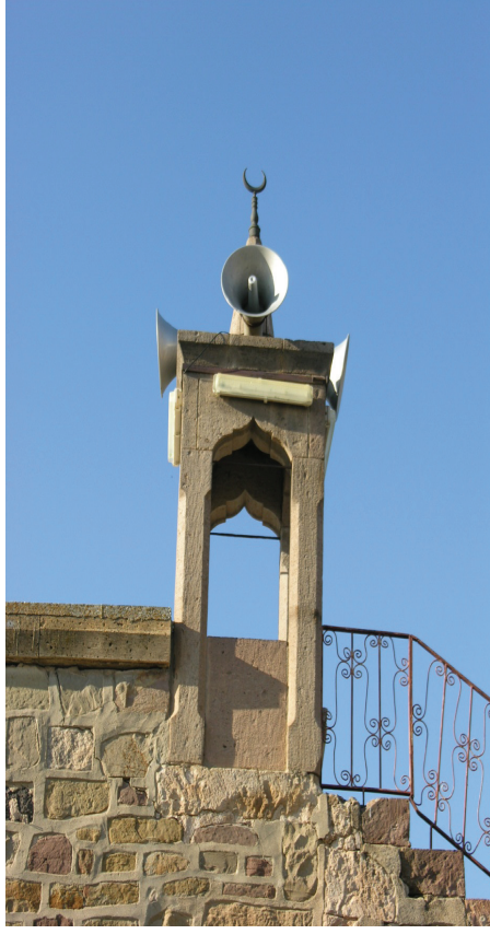
Fotoğraf 29:- Cuma Camii. Köşk (merdiven, minber) minare.
