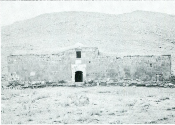
Res. 1 — Doęu cephesi
