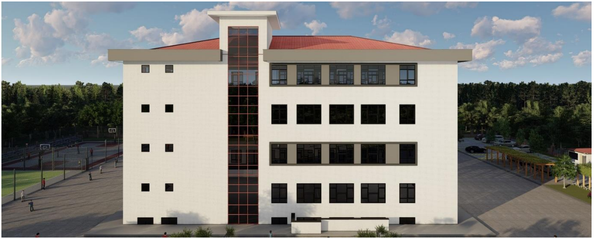
Şekil 1. Çalışma alanı olarak seçilen 12 derslikli tip ilkökul yapısı. Sivas İl Milli Eğitim Müdürlüğü Emlak ve İnşaat İşleri (2021).
