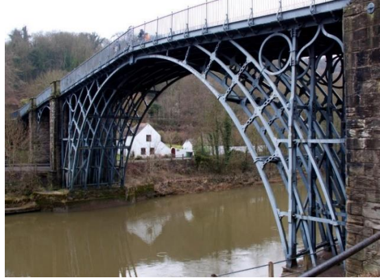
Şekil 1. Coalbrookdale Köprüsü (Url – 1)
