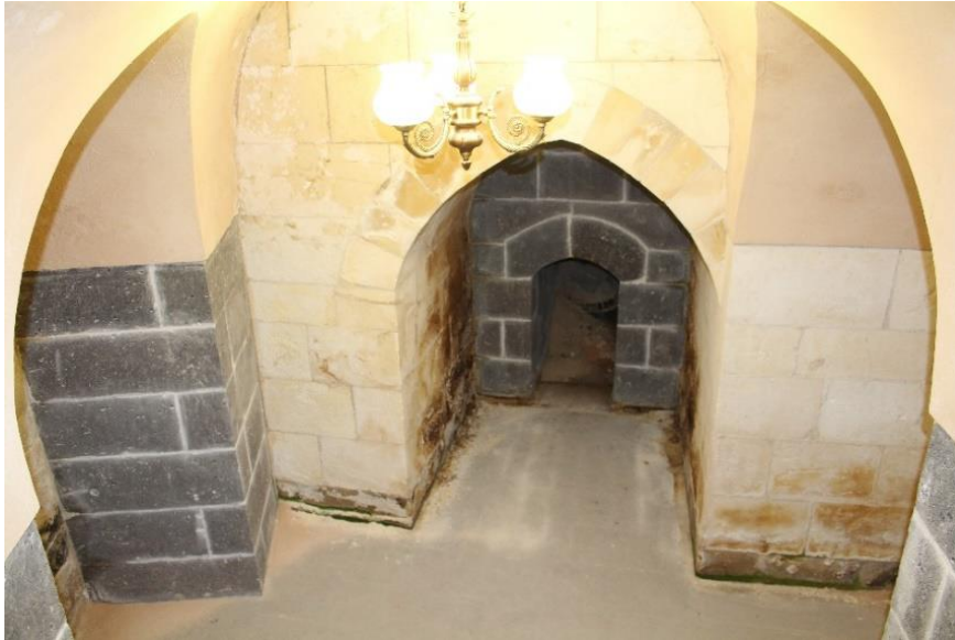
Fot. 21: Kilis Kalaycılar Sabunhanesi Ocaklık (M. Çiftyürek)
