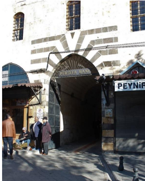
Fot. 8: Gaziantep Kürkçü Sabunhanesi Güney Cephe Ana Kapı (M. Çiftyürek)
