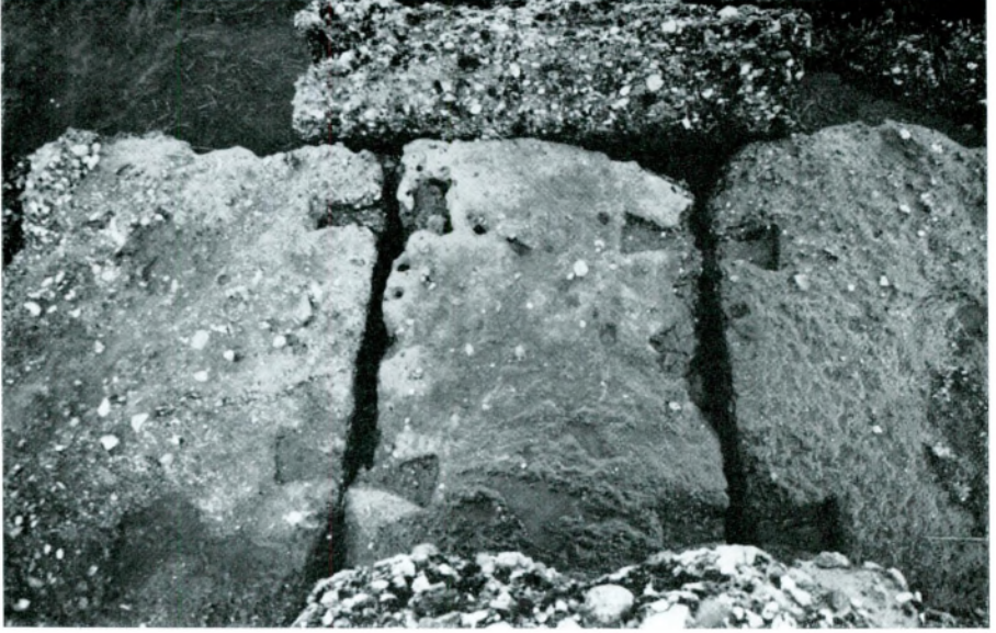
Res. 9 — Bloklar üzerinde görülen kenet izleri
