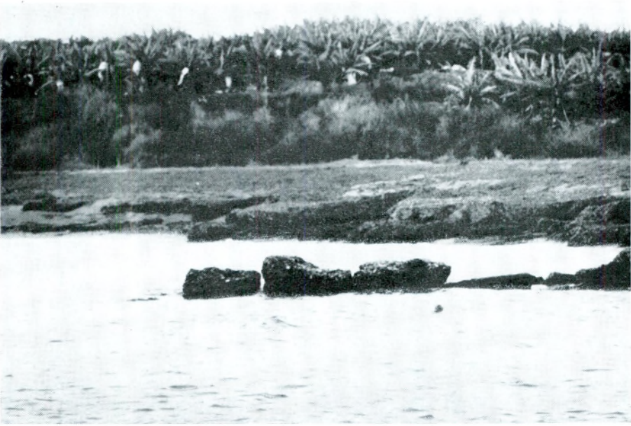
Res. 7 — Küçük mendireğe ait kalıntılar
