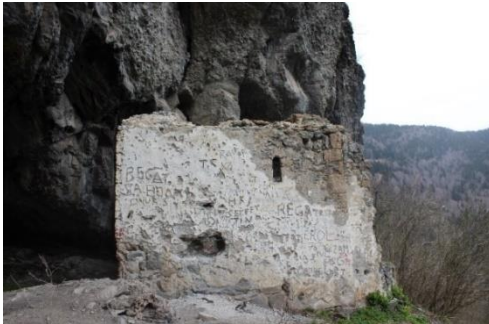
Şekil 9: Peygamber İlyas Şapeli Güney Cephe (2022)
