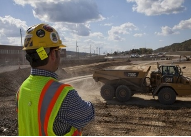
Şekil 2: Şantiyede görünürlük ve güvenlik [35]
