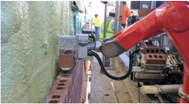
Şekil 3: SAM yarı otomatik duvarcı [60]
