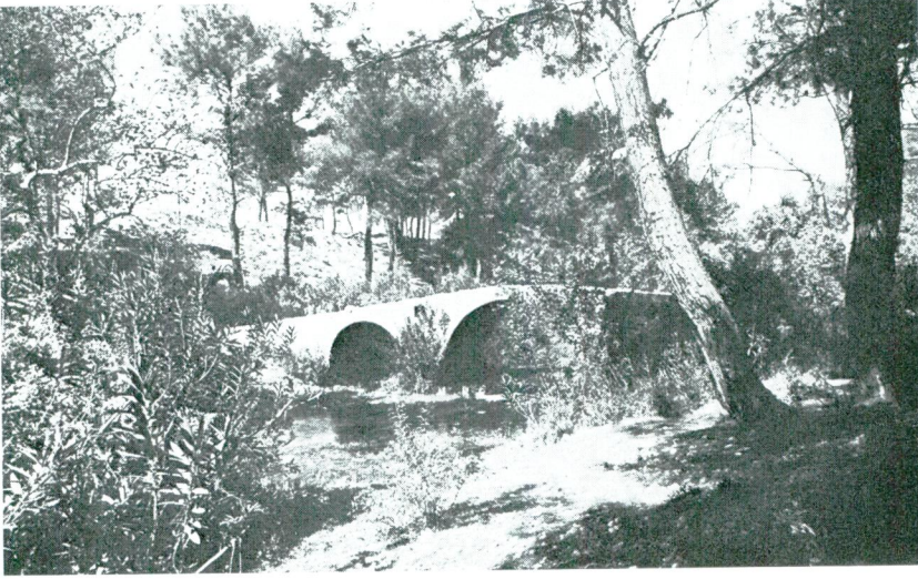
Res. 14 — Kalabaklı deresi üstündeki Hacıshali Köprüsü.
