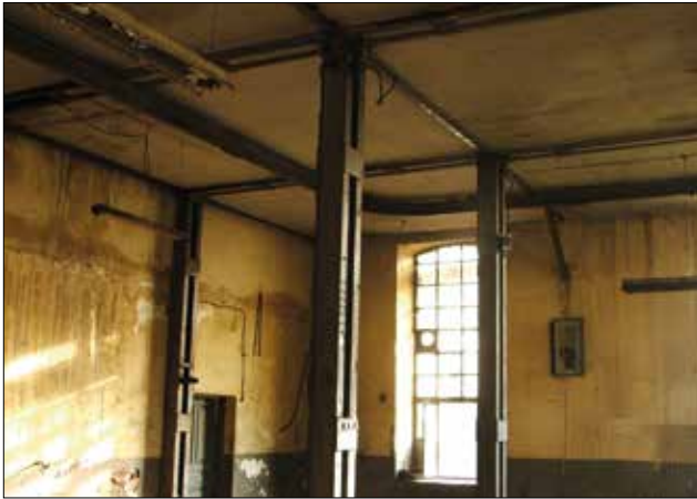
Fotoğraf 24: Asma-Dilaver Taşkömürü İşletme Müdürlüğü Lavuar Binası İç Mekân (Muhsin Maden Arşivi, 13.02.2004) / Asma-Dilaver Hard Coal Operation Directorate Coal Washing Building interior
