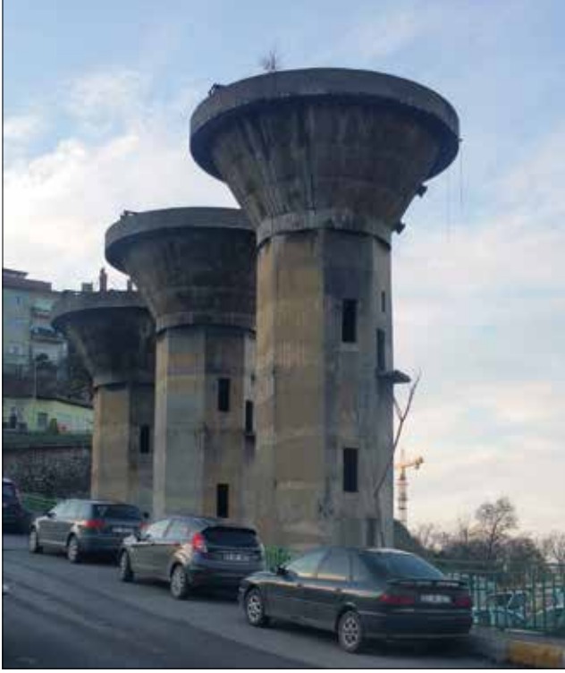
Fotoğraf 43: Merkez Lavuar Tesisi Yıkımdan Sonra Merve Varol Can Arşivi, 03.01.2020) / Central Coal Washing Plant After Demolition Demolition
