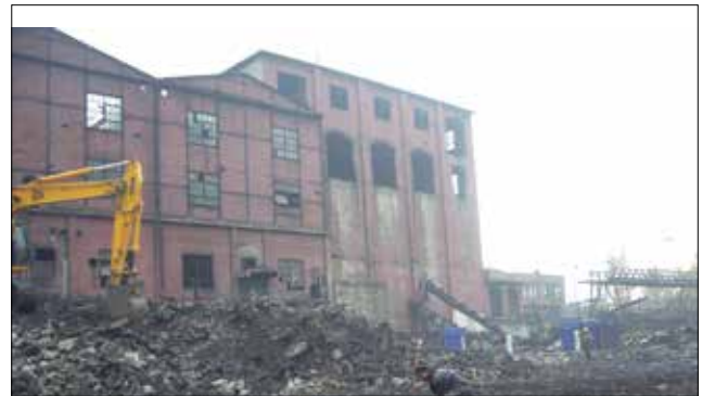
Fotoğraf 41: Zonguldak Liman'da yer alan Merkez Lavuar Tesisi (Yıkım Süreci) (TTK Arşivi, 13.11.2006) / Central Coal Washing Facility in Zonguldak Port (Before)
