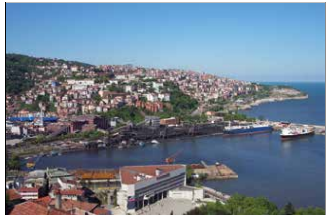
Fotoğraf 38: Zonguldak Liman'ında yer alan Merkez Lavuar Tesisi (Yıkımdan Önce) (TTK Arşivi) / Central Coal Washing Facility in Zonguldak Port (Before Demolition)
