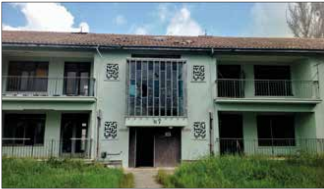
Fotoğraf 16. Ataş yerleşkesi içerisindeki apartman tipi lojman blokları (Yazarlar arşivi, 2014) / Apartment blocks in the settlement area
