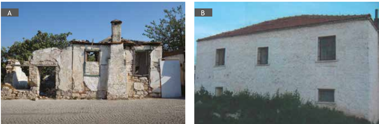
Figure 14. (a) Building with parcel no 1742, which is not worthy of registration as a cultural property to be protected (b) Building with parcel number 1797 (Source: Didim Municipality Archive). / (a) Korunması gerekli kültür varlığı olarak tescili uygun görülmeyen 1742 parsel numaralı yapı (b) 1797 parsel numaralı yapı (Kaynak: Didim Belediyesi Arşivi).
