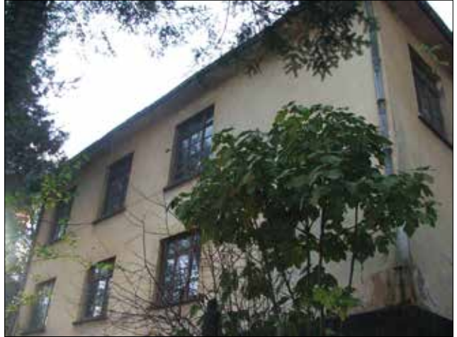
Fotoğraf 20: İdare Binası (Ece Bakiöğlü Arşivi, 16.11.2009) / Administration Building
