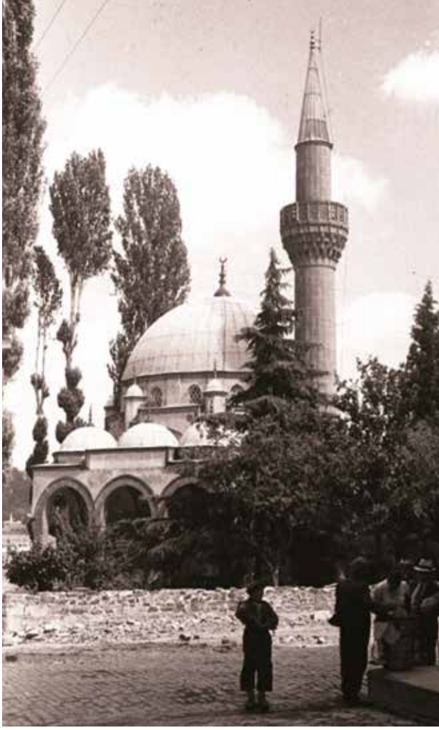
Fotoğraf 5. Bebek Camisi ve taş avlu duvarları (Joailles ve Gülmez Freres, t.y.). / Bebek Mosque and stone courtyard walls (Joailles and Gülmez Freres, n.d.) .
