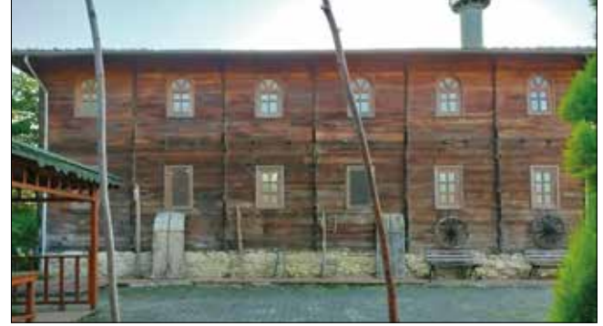
Fotoğraf 6. Doğu cephe / Eastern facade.
