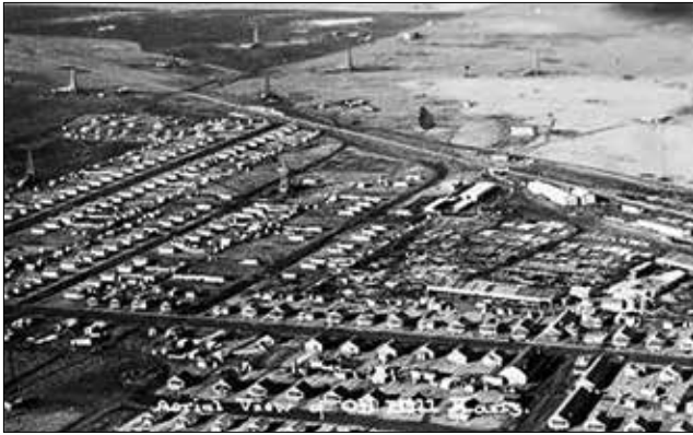
Fotoğraf 3: ABD Kansas'da verimli petrol kuyuları yakınlarında kurulan şirket yerleşimi (URL-4) / Company towns developed near oil extraction sites in Kansas, USA
