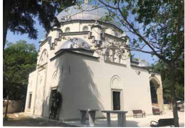
Fotoğraf 13. Caminin güney köşesi, tromp ve yarım kubbeli üst örtüsü (Fotoğraf yazar tarafından çekilmiştir, 2022). / South corner of the mosque, squinch and half-dome (Photo taken by the author, 2022).
