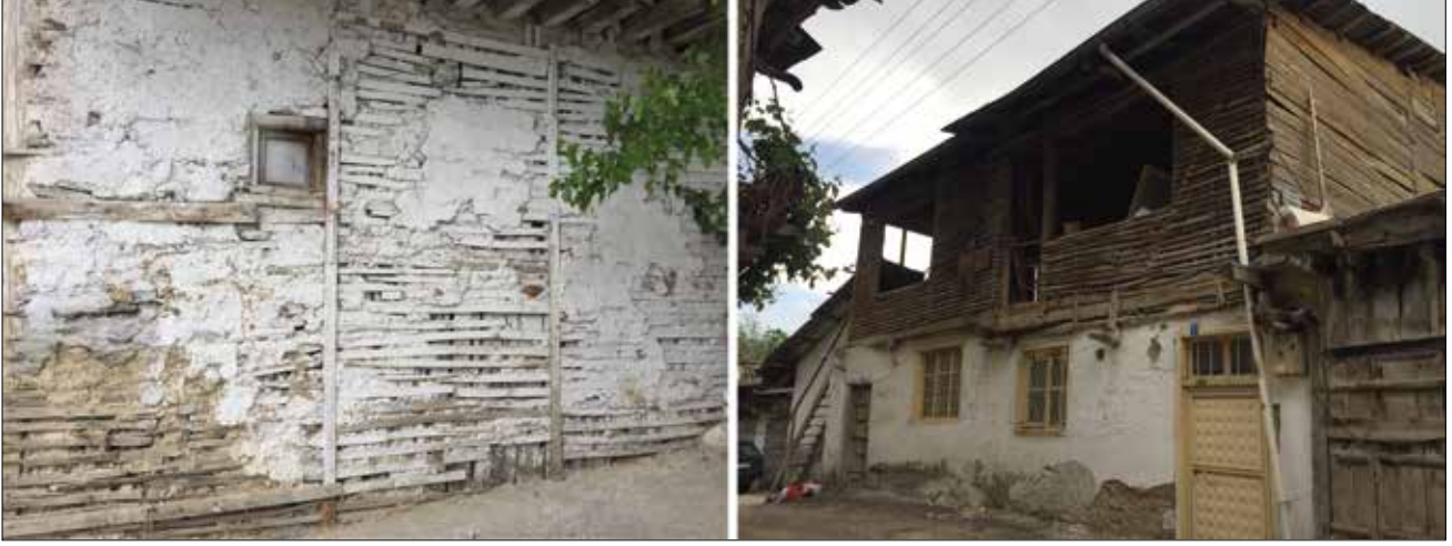
Levha 10. Ermenek kış yerleşimi, bağdadi duvarlar ve mellez sıvası / Ermenek, winter settlement, bağdadi walls and mellez plaster (Fotoğraflar, Erkovan)
