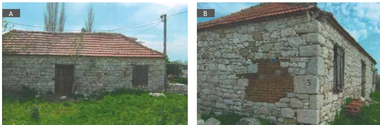
Figure 15. (a), (b) The building with parcel number 1843, which is registered as a cultural property to be preserved (Source: Didim Municipality Archive). / (a), (b) Korunması gerekli kültür varlığı olarak tescillenen 1843 parsel numaralı yapı (Kaynak: Didim Belediyesi Arşivi).
