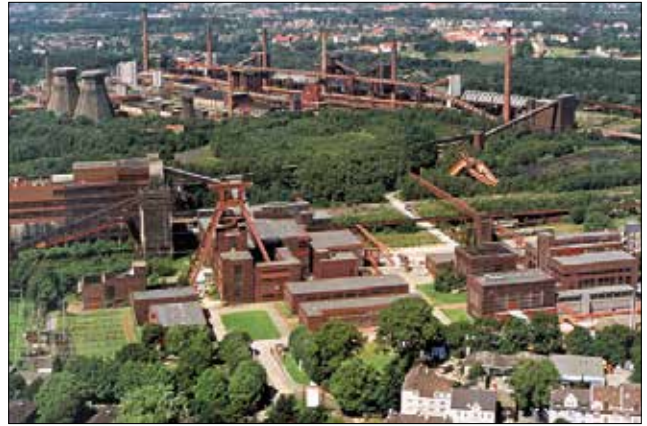
Fotoğraf 7: Zeche Zollverein Yapı Sahası ( https://www.rheinische-industriekultur.de/objekte/projekte_img_flaechendenkmale/img_flaechen/projekte_flaechen4.jpg ) / Zeche Zollverein Building Site
