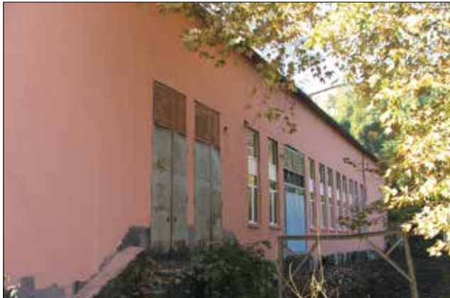
Fotoğraf 14: Kompresör Binası (Ece Bakioğlu Arşivi, 16.11.2009) / Compressor House
