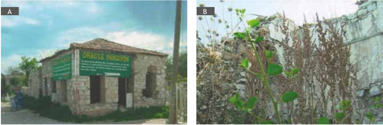
Figure 13. (a)The building with parcel number 1852, which was decided to be demolished (b) Remains of building with parcel number 1915 (Source: Didim Municipality Archive). / Yıkılmasına karar verilen 1852 parsel numaralı yapı (b) 1915 parsel numaralı yapı kalıntısı (Kaynak: Didim Belediyesi Arşivi).
