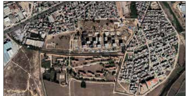
Fotoğraf 26. ATAŞ lojman sahasının günümüzdeki durumu ve yıkımlar (kaynak: Google Earth görünümü) / Present situation of ATAŞ and demolishments
