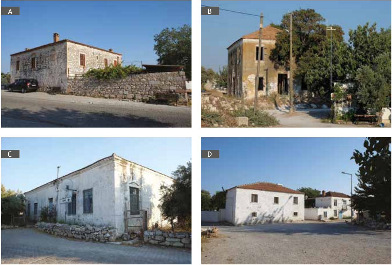
Figure 8. (a), (b), (c), (d) Traditional rural buildings in Yoran (Photos taken by Harman Aslan, 2016). / (a), (b), (c), (d) Yoran'da geleneksel kırsal yapılar (Fotoğraflar, 2016 yılında Harman Aslan tarafından çekilmiştir).
