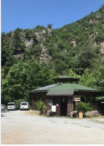
Şekil 14. Sadağı Kanyonu kafe-restoran
