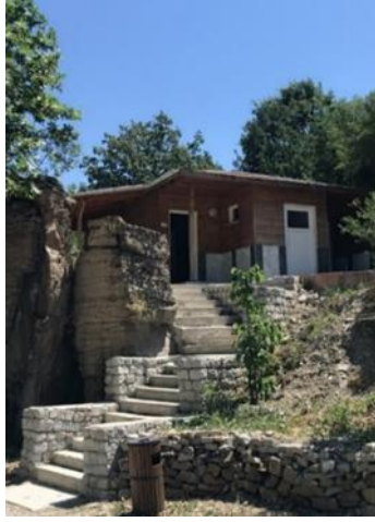
Şekil 17. Kanyon girişinde bulunan WC, lavabo
