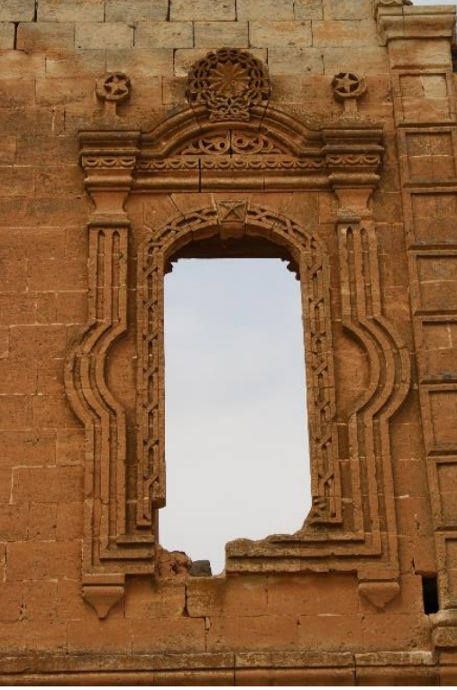
Foto. 6. Güney Cephe Pencere ve Detayları
