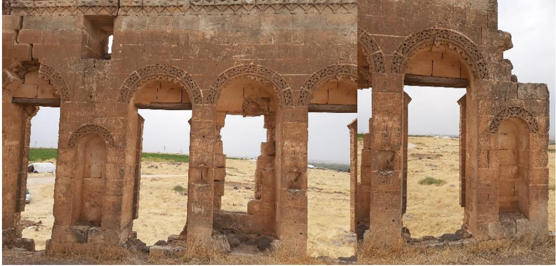
Foto. 11- 12. Batı Duvarı Genel
