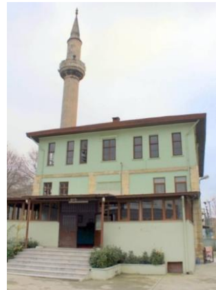
Foto. 2. Caminin 2010'lardaki durumu
