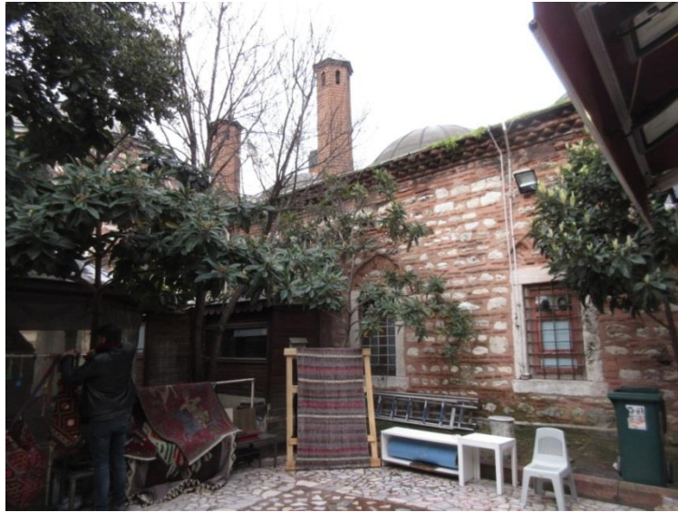
Foto. 29. Medresenin 1. Avluya bakan cephesi.
