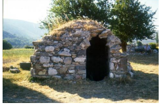
foto.2. zincirlikuyu'daki Hamamcık Güneybatı Cephesi (2001)
