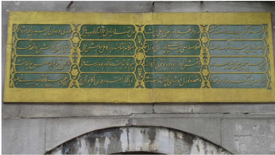
Foto. 25. Külliye'nin 2. kapısı üzerindeki kitabe.
