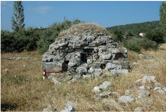
Foto.3. Hamamlıkuyu'daki Hamamcık Kuzeydoğu Cephesi, Kırık Su Haznesi (Koparal, 2017.)
