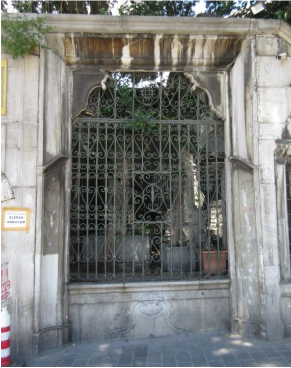
Foto. 17. 2. kapının sağındaki kemer ve çeşme izi.
