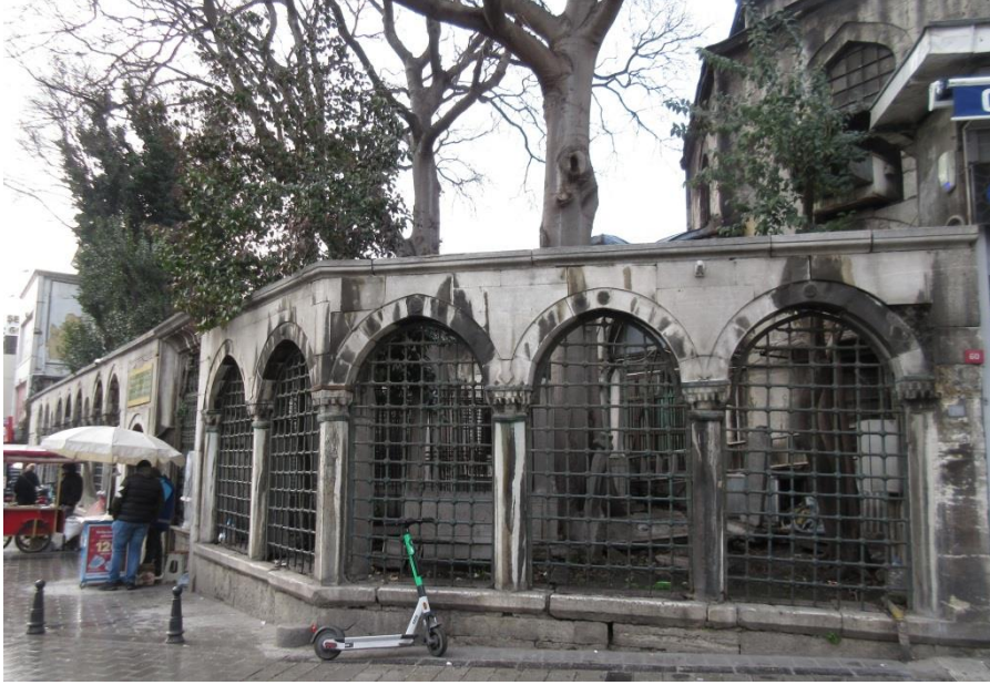
Foto. 15. Hazirenin güneydoğu köşesi.
