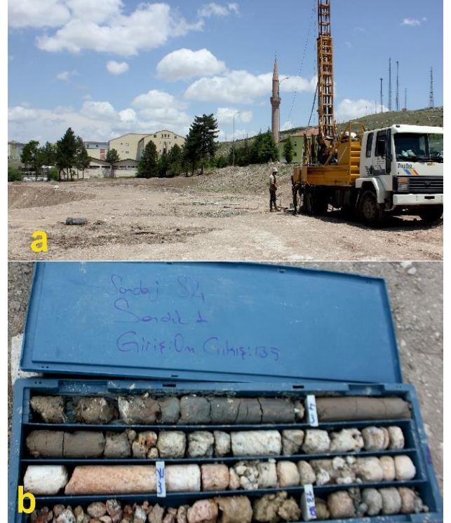
Şekil 5. a) Obruk -1 çevresinde yapılan sondaj çalışması b) Alınan karotların görünümü
