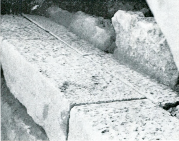
Beçin, tapınağın iç temel duvarı
