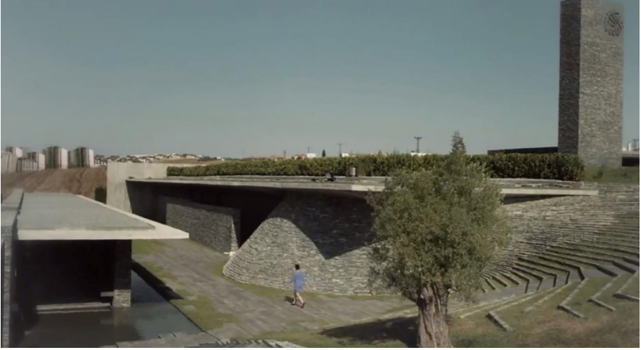
Görsel 3. İstanbul Büyükçekmece'deki Sancaklar Camii (Zaim, 2016)
