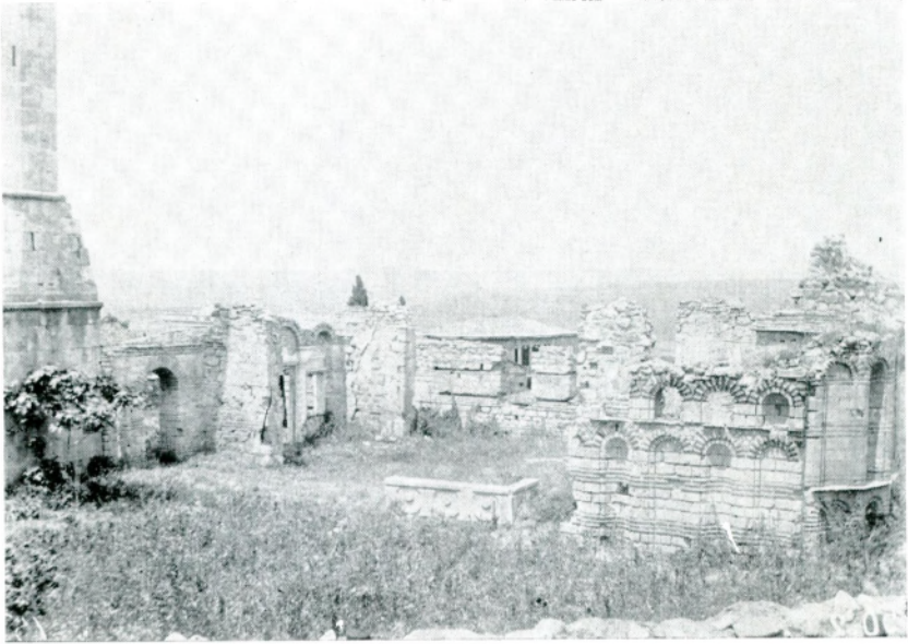
Res. 103 — Silivri kilisesi.
