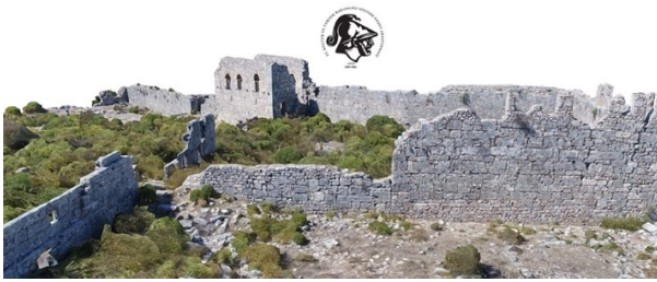
Foto 3: Kastron Yapısı 3 Boyutlu Görünümü
