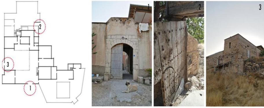
Şekil 2. Bina giriş kapıları
