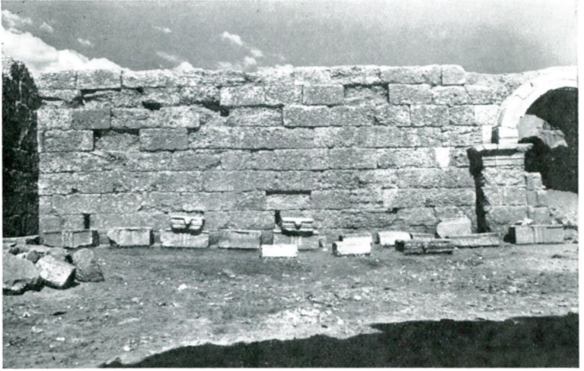
Res. 33 — Avlunun kuzey yan duvarı
