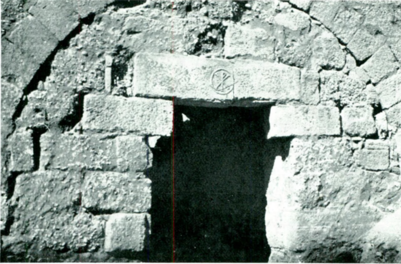
Res. 8 — C geçidinin doğu cephesi
