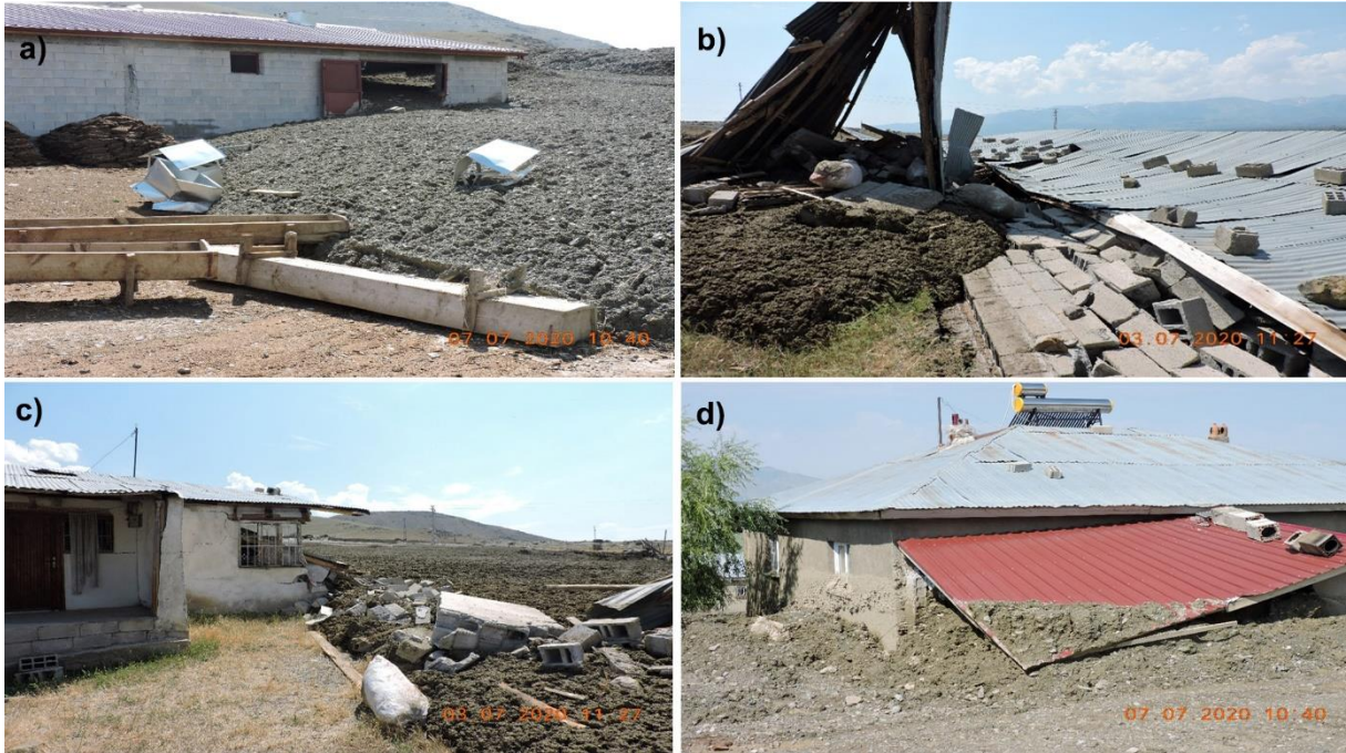
Şekil 12. 2 Temmuz 2020 tarihinde Günebakan Mahallesi'nde meydana gelen çamur akmasından etkilenen ahırlar (a, b, c) ve meskenler (d). Kaynak: Erzincan AFAD İl Müdürlüğü Afet Raporu.
