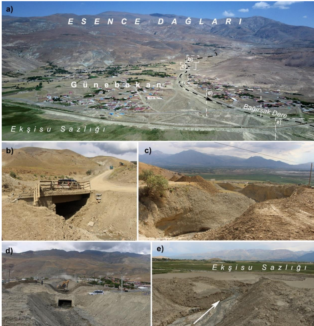
Şekil 11. Erzincan Ovası kuzeyinde Bağırsak Dere tarafından oluşturulan eğim değeri yüksek yelpaze ve çamur akması sonrasında ortaya çıkan değişimler. a) Bağırsak Dere yelpazesinin boyu eninin iki katından fazladır. Bu nedenle akışa geçen su yataktaki malzemeyi de bünyesine alarak çamur akmasına neden olmaktadır. b) Yelpazenin kök kısmında yatak daraltılmıştır. c) Yelpazenin eğimi yüksek olduğundan akışa geçen su kök kısmındaki dolguları yarmıştır. Böylece yukarı havzada toplanan su yelpazede dağılmamaktadır. d) Yelpaze üzerindeki yatak geniş olsa da yol geçişlerinde daraltılmıştır. e) Çamur akmasıyla taşınan malzeme Ekşisu Sazlığına kadar ulaşarak sazlıkta siltasyona neden olmaktadır.
