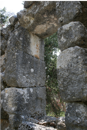
Fig. 8a. D30 No'lu Konut Balkon İkinci Kat Kapısı İç Cepheden Görünüm.
