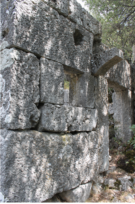
Fig. 84. D9 No'lu Konut Dış CephedenKapı, Pencere ve Tonoz Ayakları.
