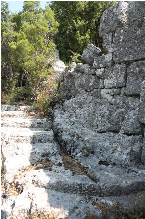
Fig. 83b. D9 No'lu Konut Anakayadan Merdivenli Sokak.
