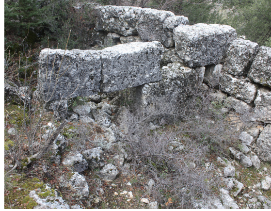
Fig. 35a. D2 No'lu Konut Doğudaki Avlu İç Kısım ve Doğudaki İlk Mekâna Geçişi Sağlayan Kapı.
