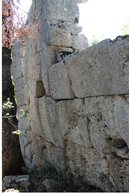
Fig. 7. D30 No'lu Konut Doğu Kısım-da Eklenen Avlu Duvarları.
