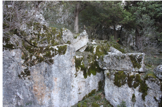
Fig. 56. B4 No'lu Konut Ana Kaya Kuzey Cephe ve İkinci Kat Zeminin Oturduğu Kısımlar
