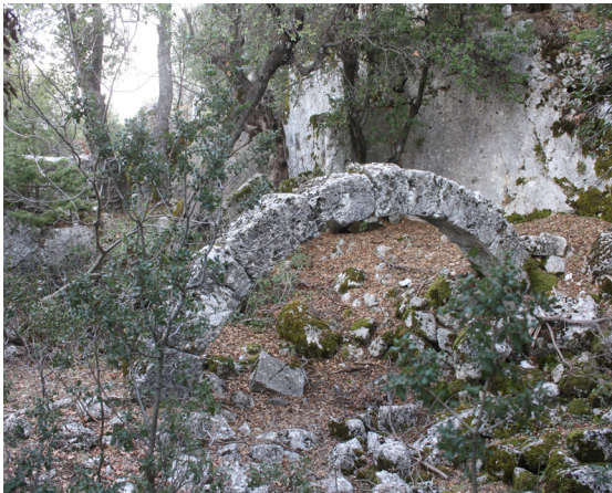
Fig. 37. D2 No'lu Konut İlk İkinci Mekâna Ait Kemer.
