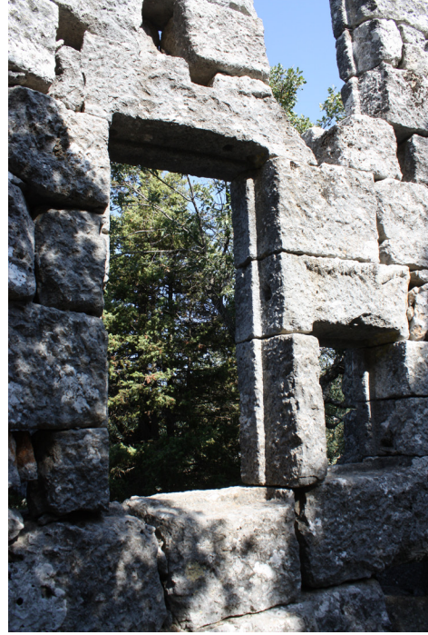
Fig. 50a. B1 No'lu Konut Balkon Kapıları İç Cepheden.
