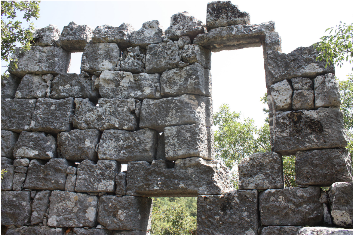
Fig. 48. B1 No'lu Konut İç Cepheden Katları Ayıran Hatıl Delikleri, Kapı ve Pencereler.
