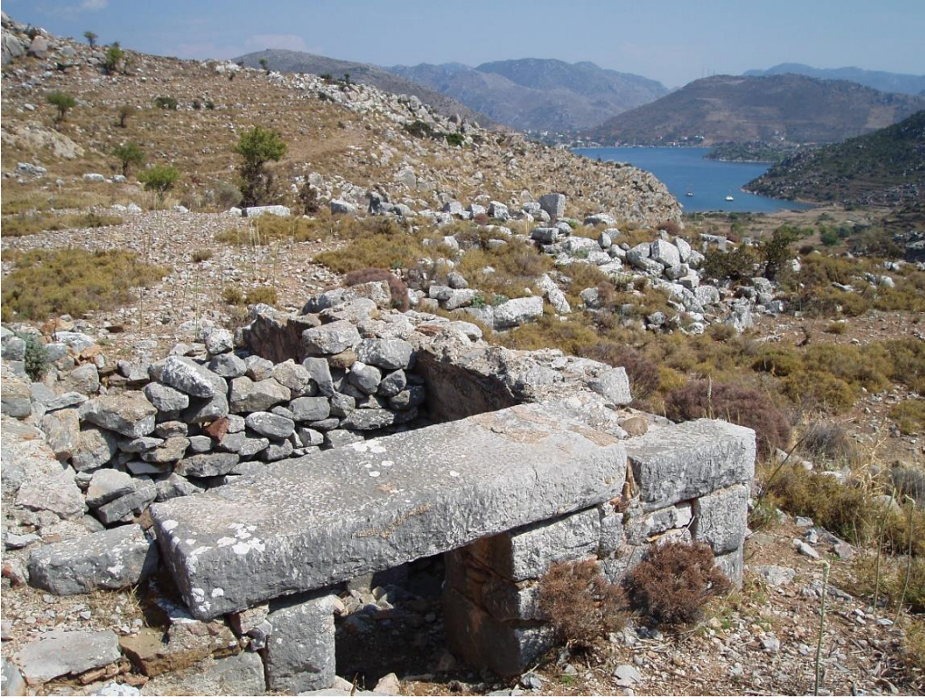
Fig.20: Çiftlik yapısı, Örteren, Bozburun.
