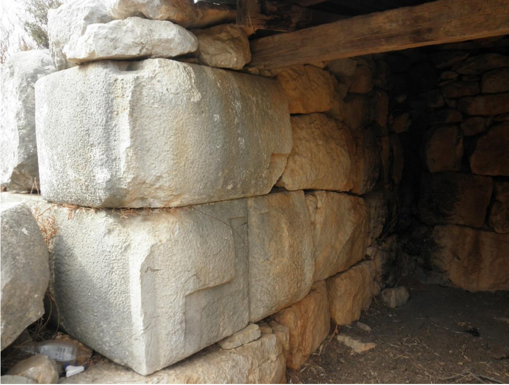
Fig.3: Büyük devşirme blokların kullanıldığı ağıl yapısı, Taşlıca.
