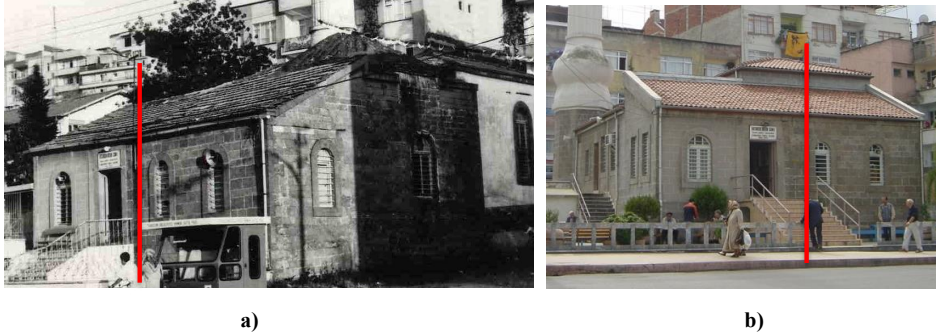
Şekil 13. Kuzey duvarındaki malzeme ve pencere ebatlarındaki uyumsuzluk (V.G.M Arşivi)
