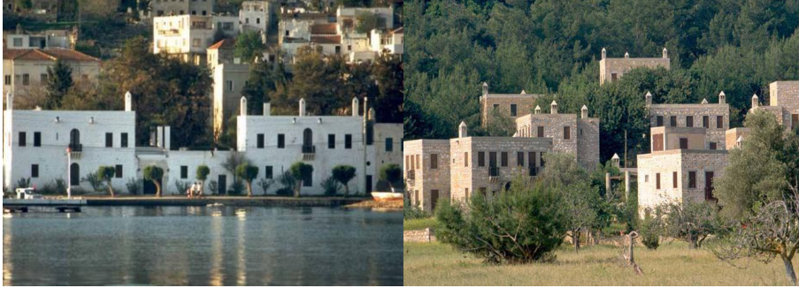
Şekil 4 ve 5: Ertegün Evi (sol) ve Demir Tatil Köyü (sağ) (Kaynak: http://www.mimarhane.org/turk_tarih_kurumu )
