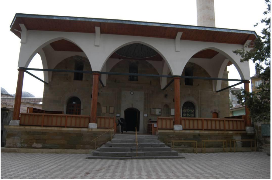
Fot. 2. Merzifon Paşa Camisi
