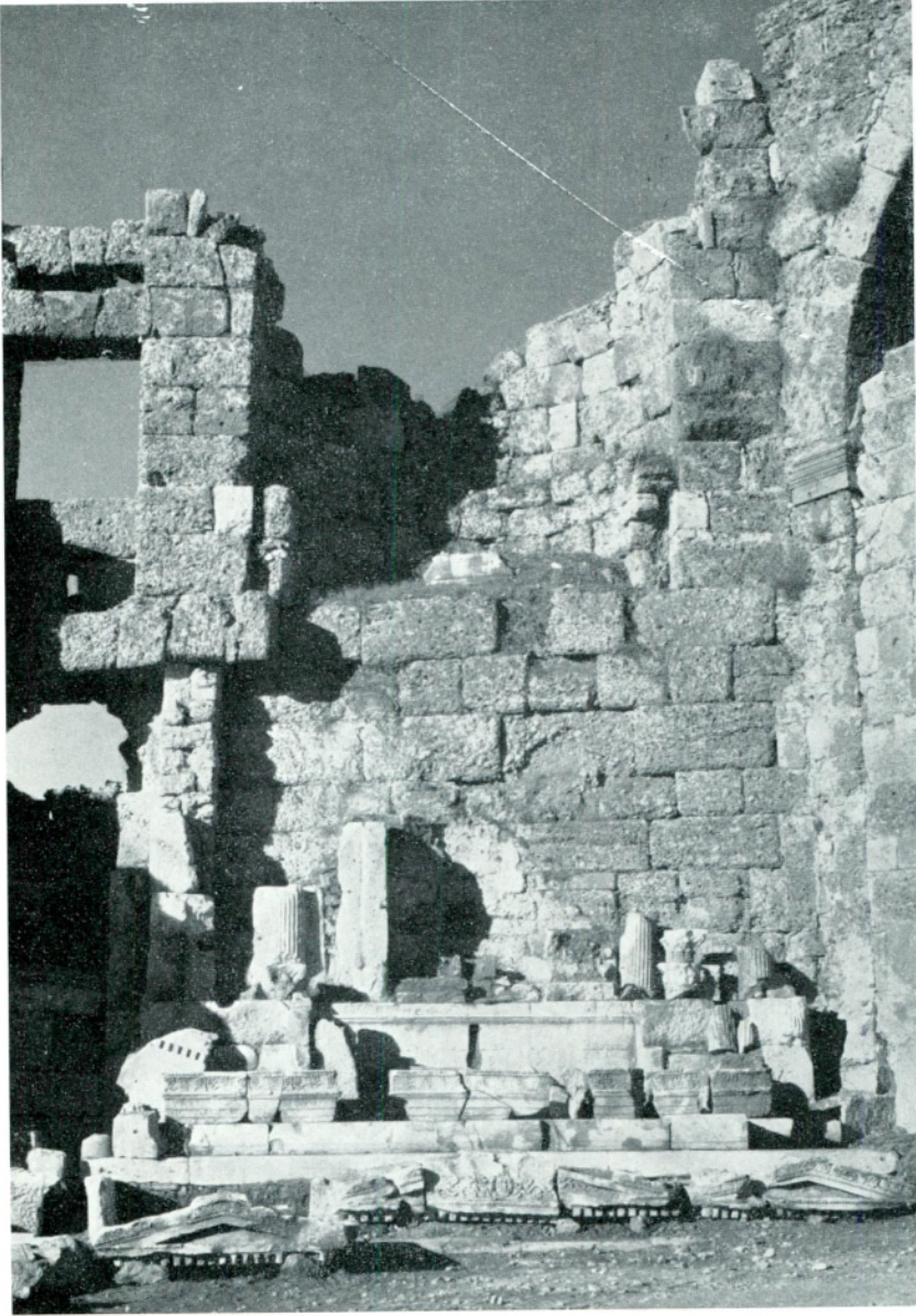
Res. 1 — “Vespasianus anıtı” ve gerisindeki duvar. Kazıdan sonraki durum. Abb. 1 — Das “Vespasiansmonument” und die hintere Mauer. Zustand nach der Grabung.
