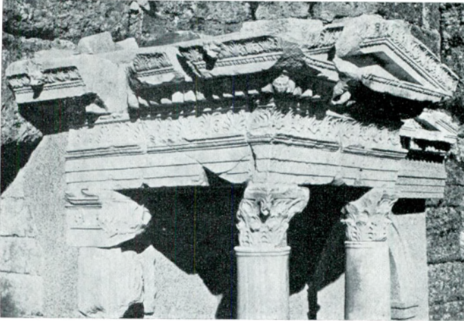
Res. 33 — Restore edilen sol aedicula'nın üst kısmı. Abb. 33 — Oberer Teil der wiederhergestellten linken Aedicula.
