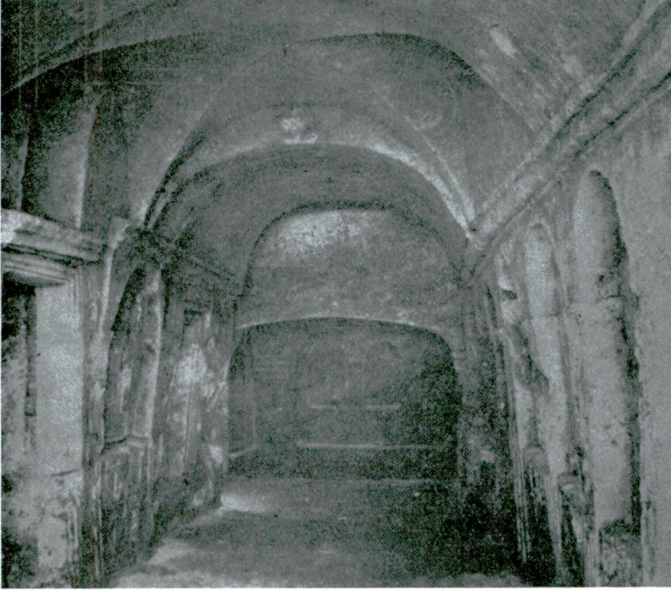
Res. 7. Aynı yerin fotoğrafı, 1961 Haziranındaki durumu. (Foto, I. Hattatoğlu).
