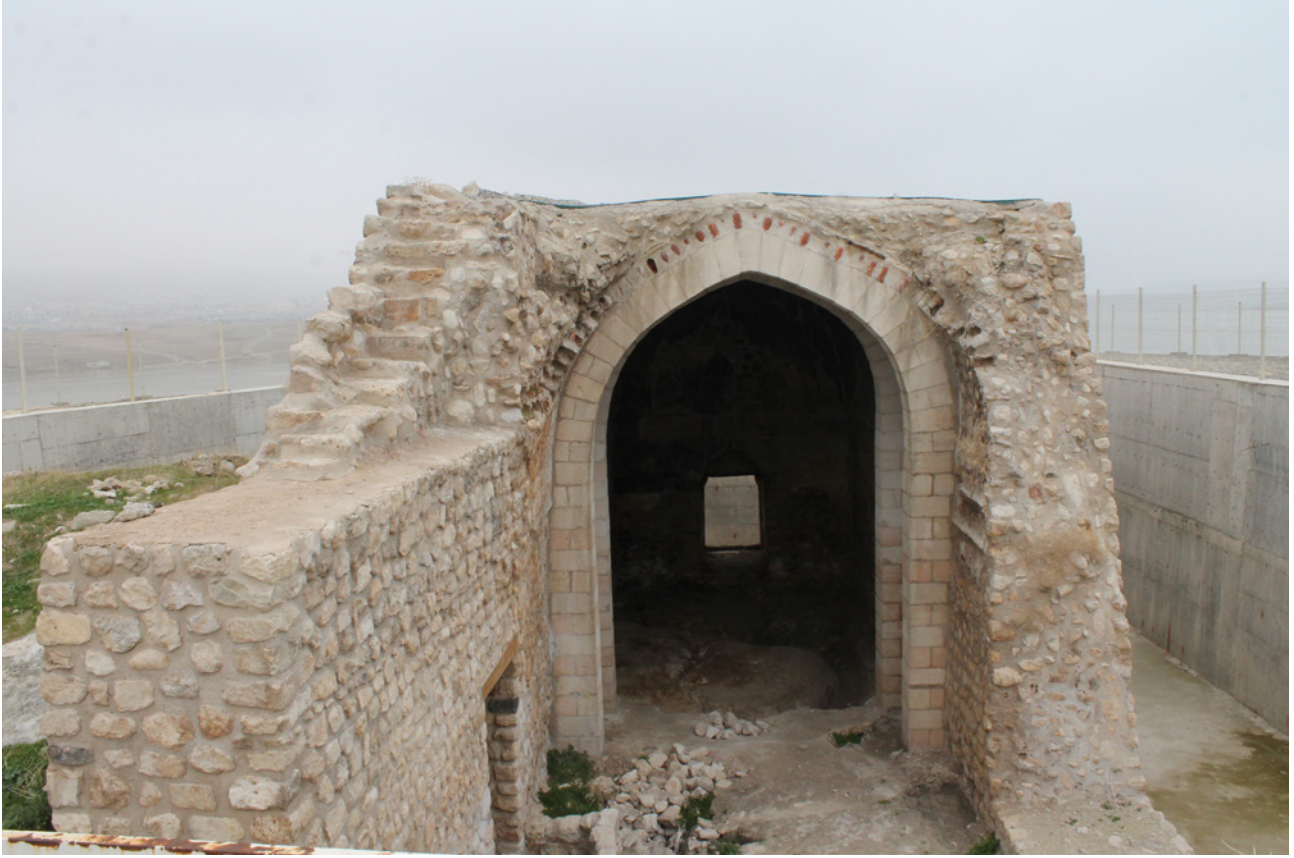
19 Küçük Saray'ın güneybatıdan görünümü, 2020
