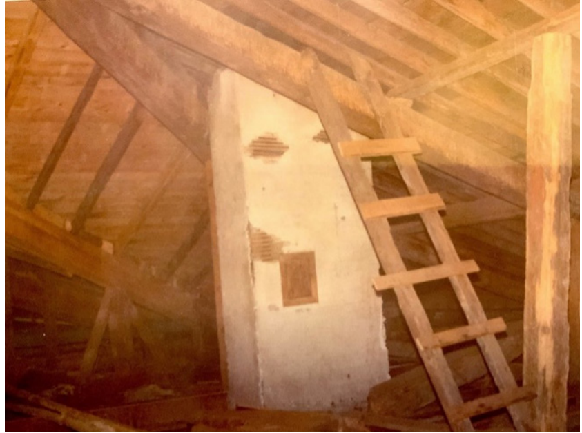
Şekil 1 Galatasaray Lisesi Tefvik Fikret Konferans Salonu havalandırma sistemi 1a Tefvik Fikret Salonu'nun kesiti 1b Çatı arasında görülebilen havalandırma sistemi
