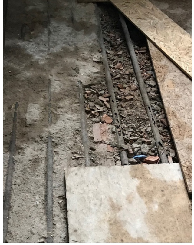
Şekil 2 Çamlıca Kız Lisesi / Ahmet Ratip Paşa Köşkü banyoları ve yerden ısıtma sistemi kalıntısı
