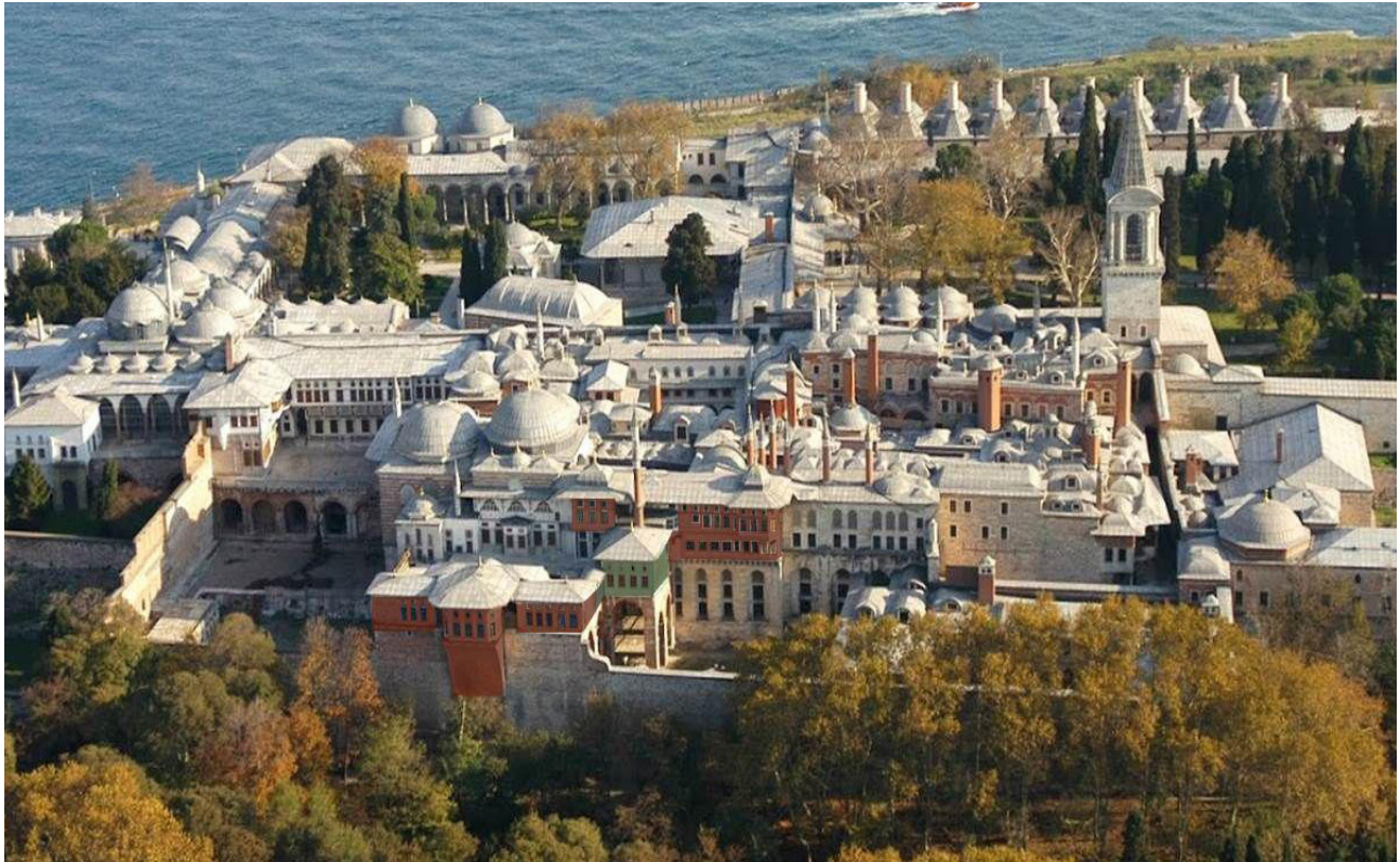
Şekil 21 Renk bulguları doğrultusunda hazırlanan cephe görünümü (Güryapı Arşivi)
