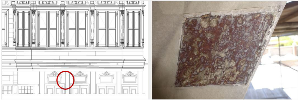
Şekil 18 Mihrişah Valide Sultan Dairesi'nin cephesi, Nokta 1, yakın çekim (Güryapı Arşivi)
