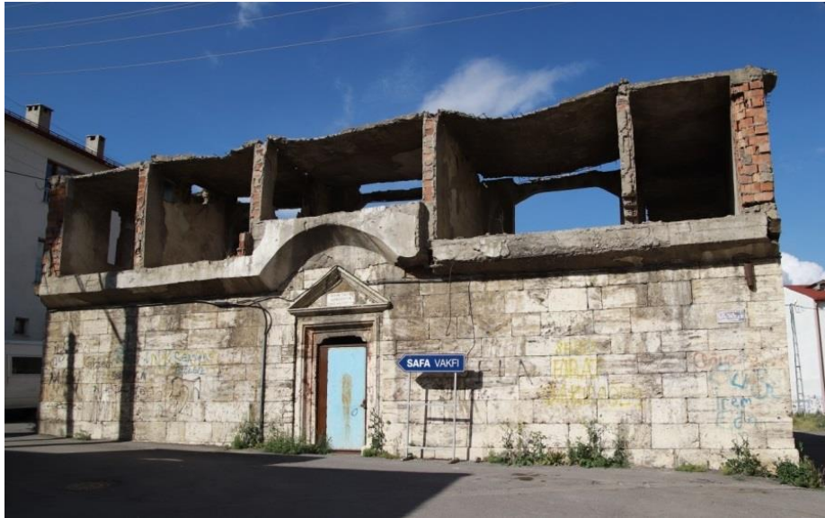
Şekil 2. Şirinoğlu Hamamı Güneybatı cephesi (Kişisel Arşiv, 2021)
