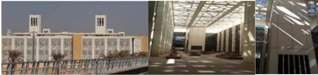
Şekil 21. Prensess Nora Üniversitesi Binasından (Suudi Arabistan) rüzgâr kepçesi örneği (Melikoğlu 2018)
