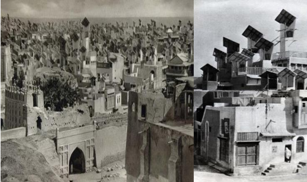
Şekil 17. Pakistan’ın Haydarabad şehrinde rüzgâr kepçesi örneği (Melikoğlu 2018)
