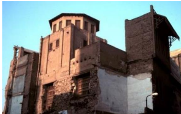
Şekil 13. Mısır'dan malkaf (Rüzgâr Kepçesi) örneği Al-Suhaymi Konağı (Melikoğlu, 2018)
