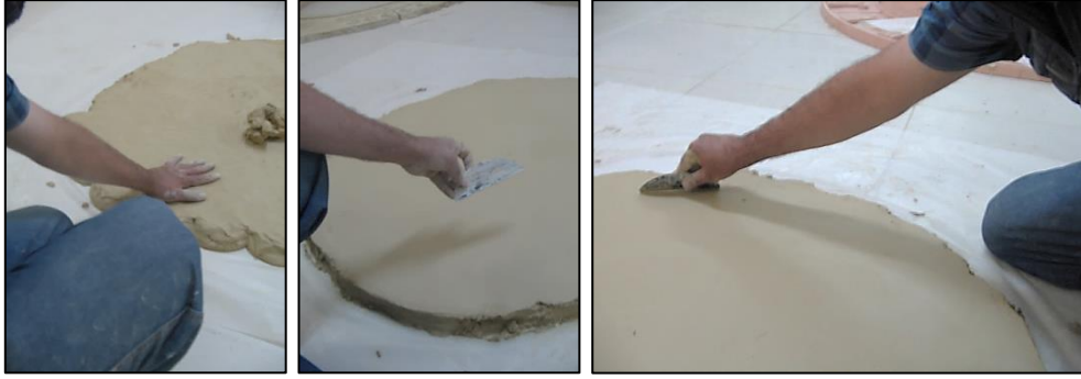
Görsel 7. Yüzeyin sistre yardımıyla düzeltilmesinin yapılması.
