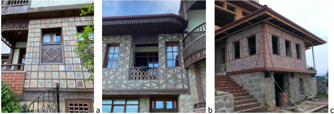
Görsel 3. Kaf Dağı Konak Otel'in göz (a) ve muskalı (b) dolma görünümlü cepheleri, mescidin yığma taş duvarı (c)
