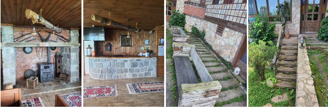
Görsel 4. Otel lobisinde doğal taş uygulamaları ve dış peyzajda kullanılan ahşap traversler
