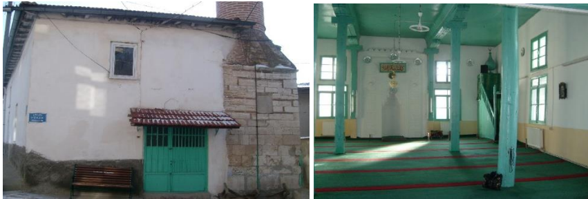
Şekil 27. Bodur Camii kuzey cephe
