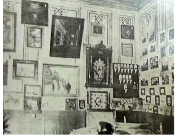
Şekil 13. Sergi Dairesi İttihaz Edilen Bursa Daire-i Belediyesi
