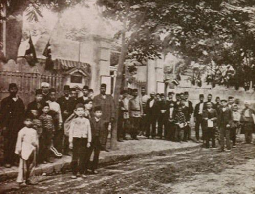
Şekil 15. Sergi Dairesi İttihaz Edilen Bursa Daire-i Belediyesi
