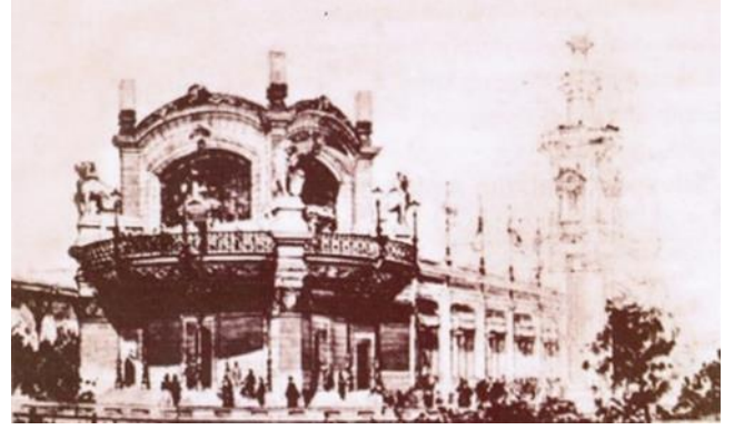
Şekil 3. 1894'te Dersaadet Ziraat Ve Sanayi Sergi Binası.
