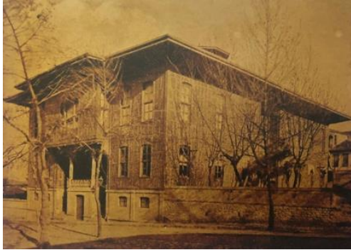
Şekil 11. Sergi Dairesi İttihaz Edilen Bursa Daire-i Belediyesi
