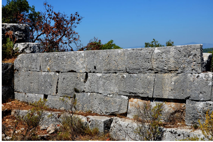
Şekil 8. Trisa Heroon'u Isodom Trapezoidal Örgü
