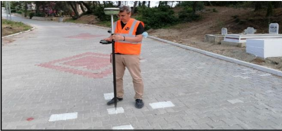
Şekil 12. YKN Ölçülmesi İşlemi
