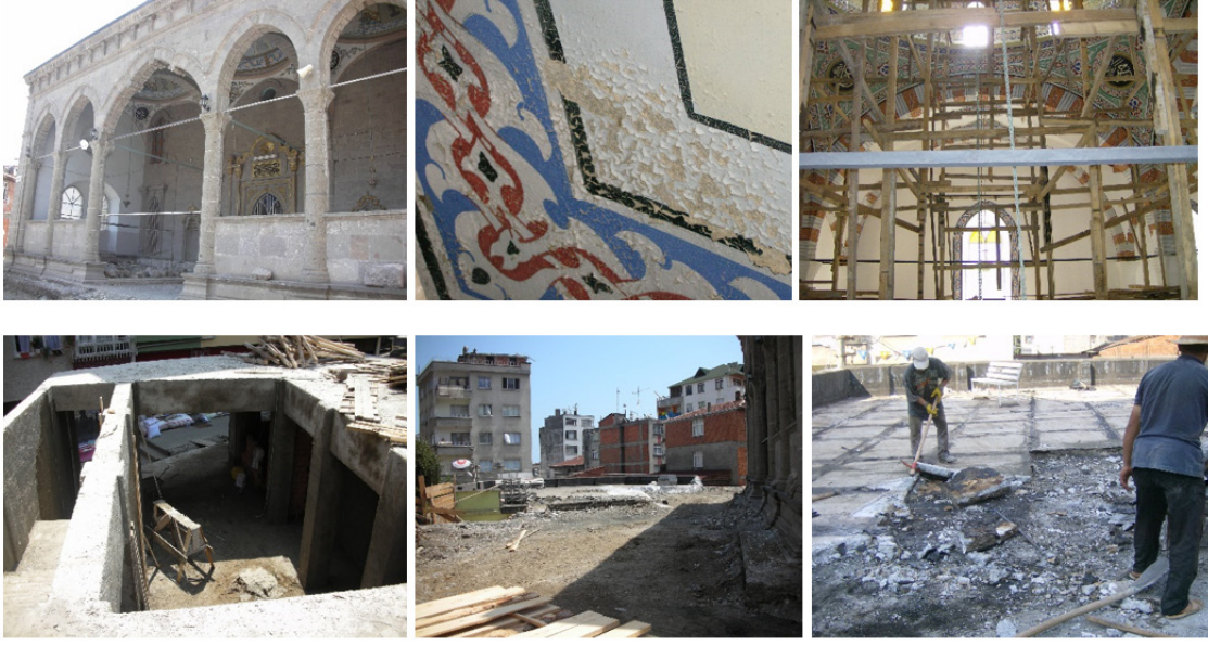
Resim 13. Yeni Cami Restorasyon Aşamasına Ait Fotoğraflar
