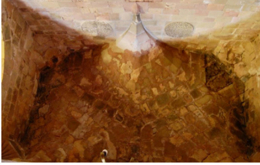
Resim 11. Divriği Ulu Camii 180° açılı kenar tonozu.
