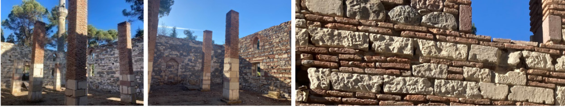
Görsel-12a-b-c: Sıva raspası yapıldıktan sonra beden duvarları ve kolonlar
