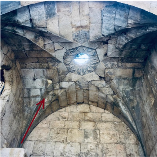
Şekil 5. Temelinde bir çapraz tonoz planı olan 3 kenarlı Alara Han çeşme eyvan tonozu.
