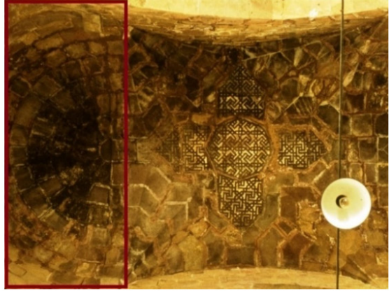
Şekil 4. Tek bir yanda yarım kubbe ile çözümlenmiş beş kenarlı Divriği Kompleksi tonozu.
