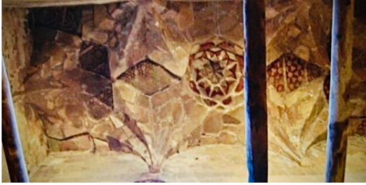
Resim 13. Divriği Ulu Cami 180° açılı kenar tonozu.
