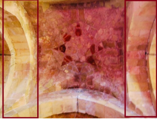
Şekil 3. İki yanda kemer eklenerek kareye indirgenen üç kenarlı Divriği Kompleksi tonozu.
