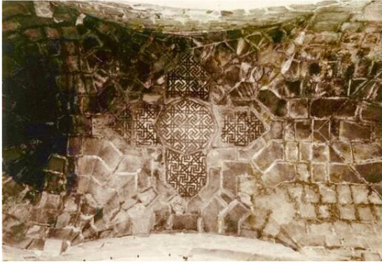
Resim 8. Divriği Ulu Camii beş kenarlı tonozu.
