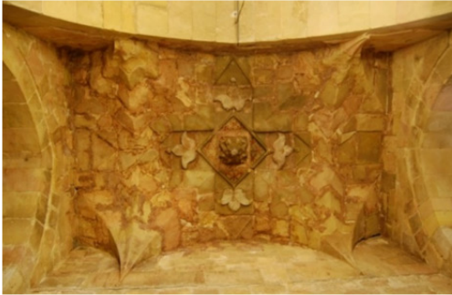
Resim 12. Divriği Ulu Cami 180° açılı kenar tonozu.
