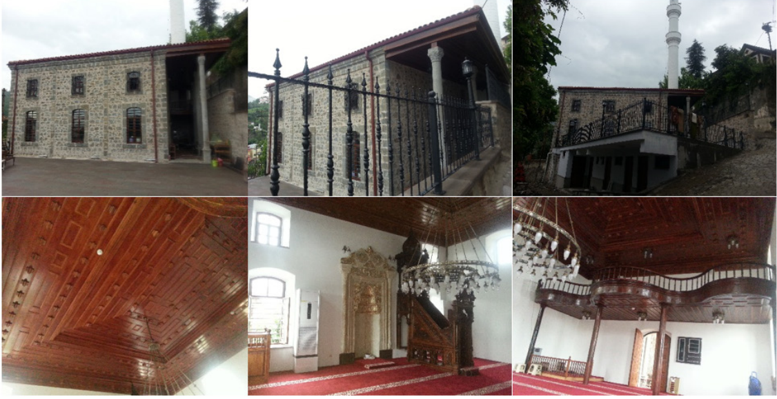
Resim 20. Orta Mahalle Camisi restorasyon sonrası görüntüleri
