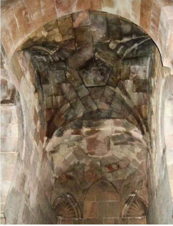
Resim 4. Divriği Şifhanesi kuzey eyvan iki kenarlı tonozu.
