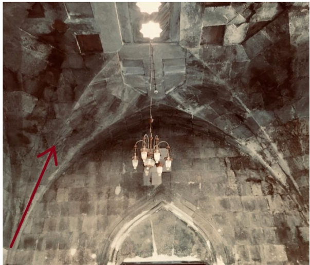
Şekil 6. Temelinde bir haç tonoz planı olan 5 kenarlı İğdir Kervansarayı tonozu.
