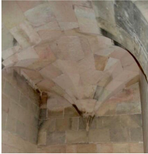
Resim 14. Divriği Şifhanesi 180° açılı kenar tonozu.
