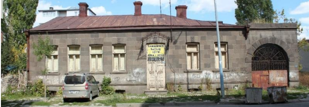
Fotoğraf 1: Topçu Evi kuzeydoğu cephesi.
