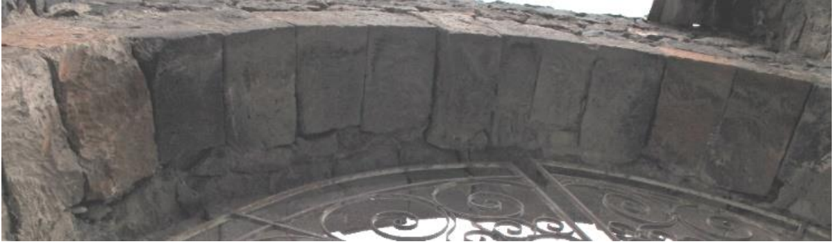
Fotoğraf 7: Kemerli avlu kapısındaki denge problemi.
