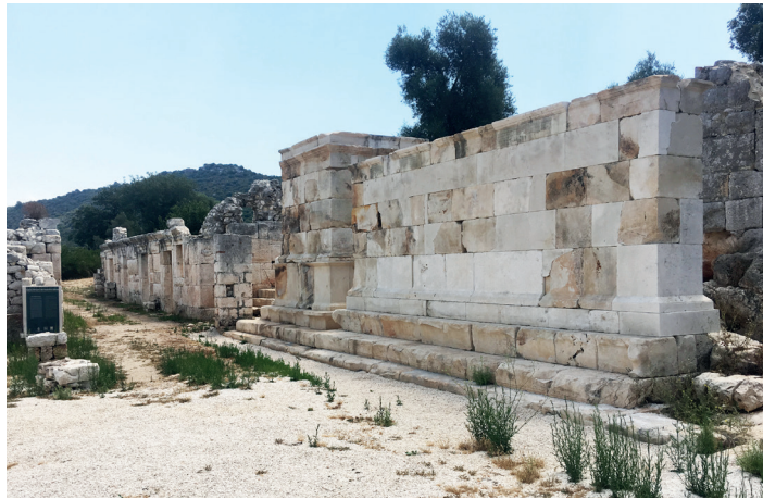
Fig. 16. Memorial Monuments and Harbour Road. Fig. 16. Onurlandırma Anıtları ve Liman Sokağı.
