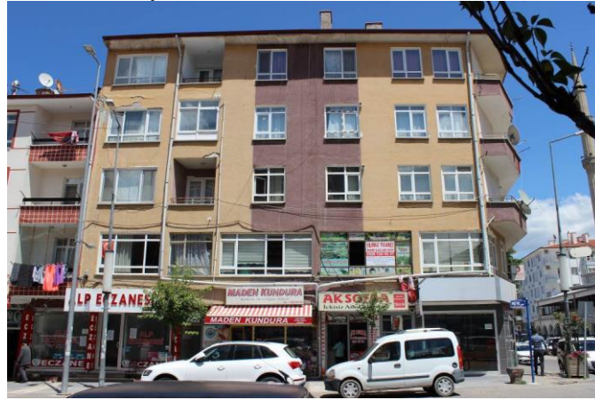
Şekil 2. 20 Nolu bina-eski hali
