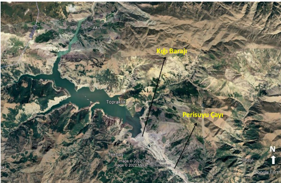
Şekil 2. Kiğı Barajı (Google Earth, 2022).
