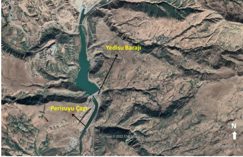
Şekil 3. Yedisu Barajı (Google Earth, 2022).
