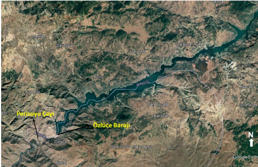
Şekil 4. Özlüce Barajı (Google Earth, 2022).
