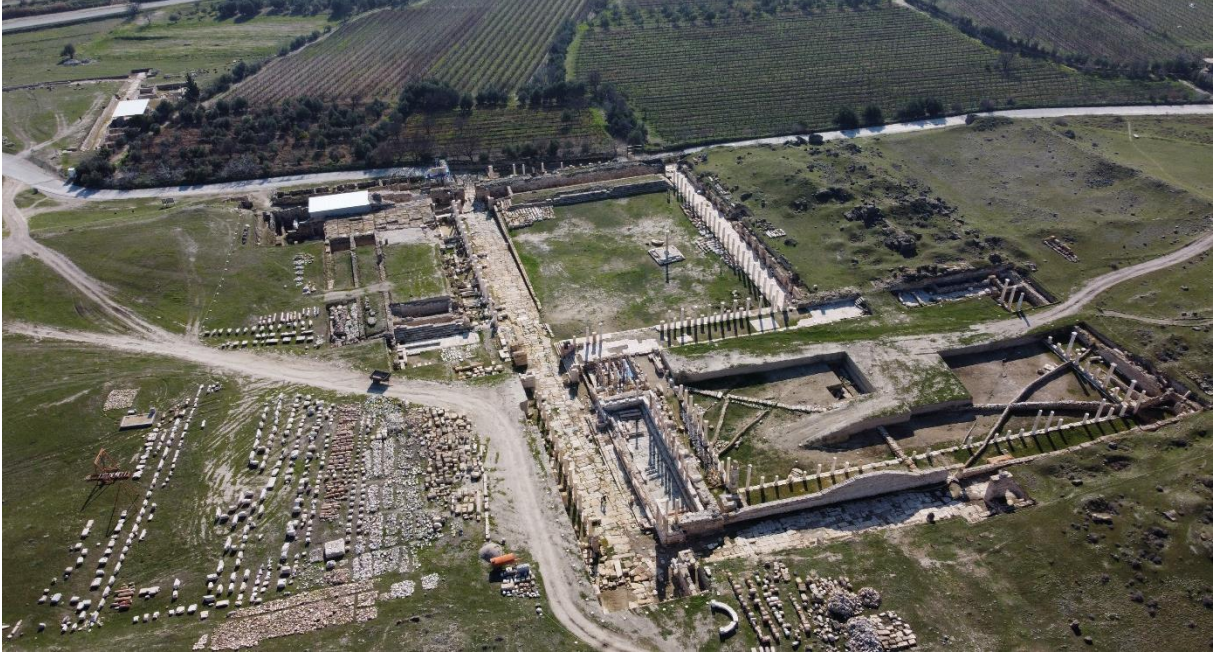
Fig. 4. Kent merkezindeki ana cadde ve etrafındaki kamu yapıları
